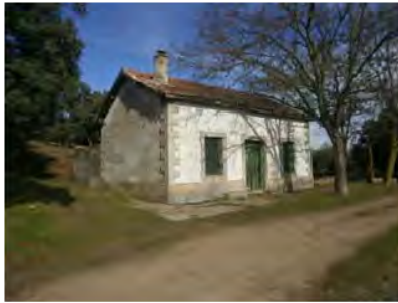
Casa del canal
