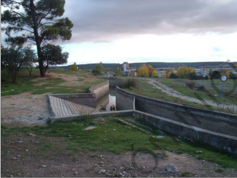
Canal de Aranda en las proximidades del Monte de La Calabaza
