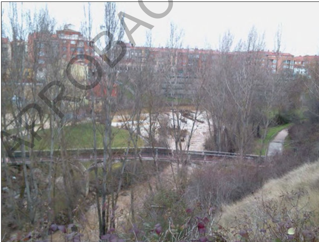
Pasarela que comunica el paseo fluvial de la margen izquierda con el Parque de La Isla.
