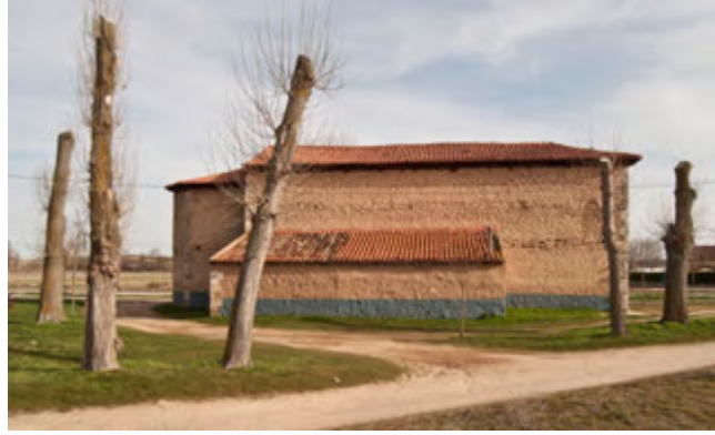
Vista del lateral norte y del cuerpo añadido.
