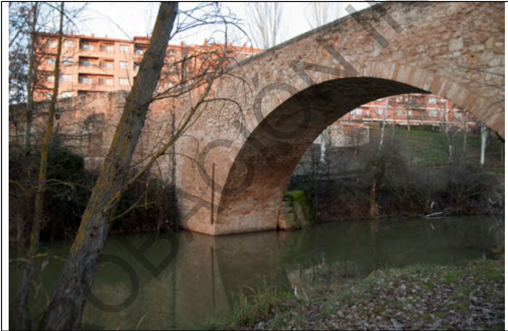
Vista del puente de Conchuela, fotografía tomada desde el suroeste en sentido norte
