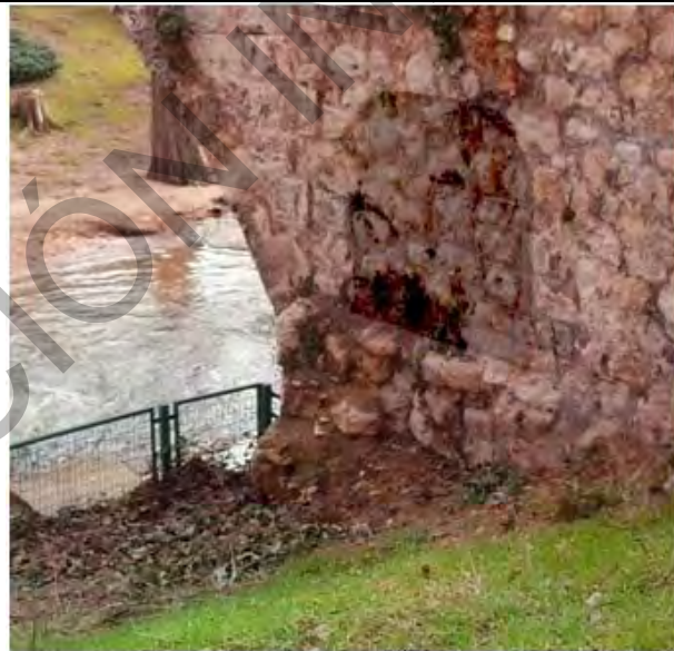
Detalle del segundo ojo del puente.
