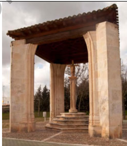
Vista del crucero y de la cubierta que lo protege. Sitio en el entorno oriental de la ermita
