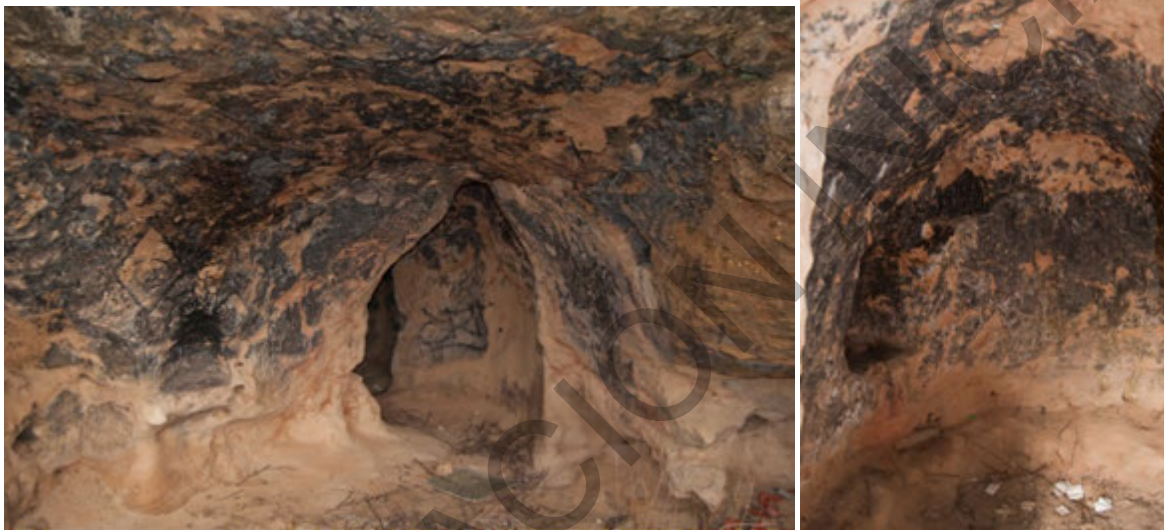
Lugar de habitación rupestre señalado con el Nº 1, detalle del umbral de entrada y de la habitación interior.
