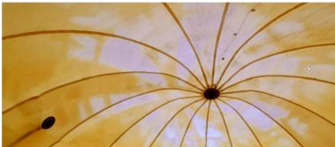
Puede comprobarse que la tela ha llegado al final de su vida útil. Se procede a dejar sin presión y a quemar el CH<sub>4</sub> que se obtiene del proceso de depuración.
