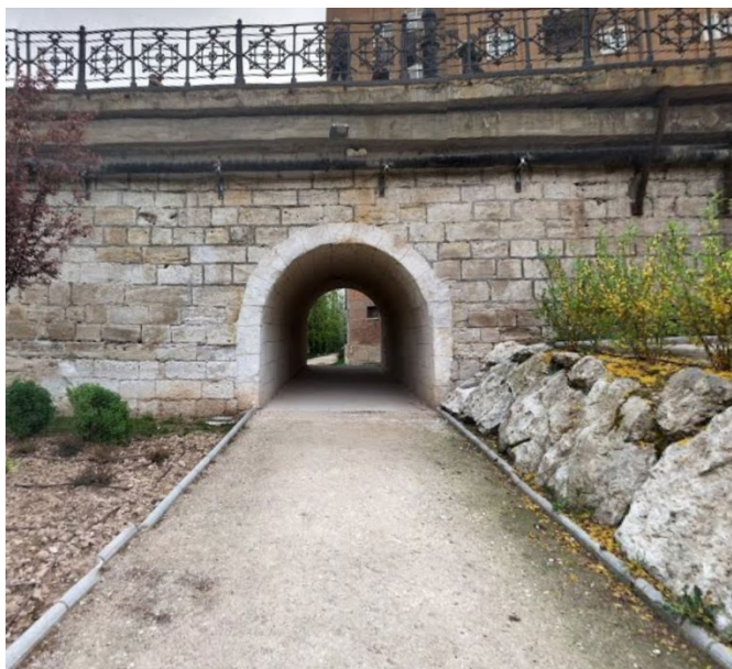
Figura 20. Conexión peatonal subterránea entre puentes del Río Duero
