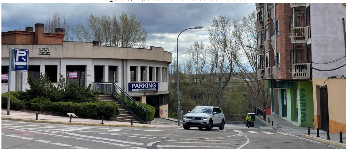
Figura 67. Aparcamiento Sol de las Moreras
