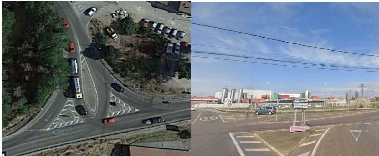
Figura 32. travesía a tratar en la CL-619
