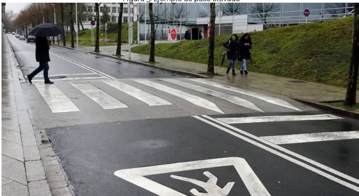
Figura 3. Ejemplo de paso elevado
